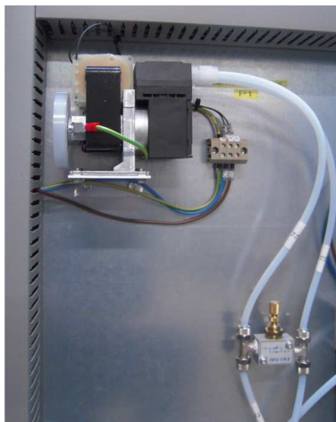
Figura 5: Pompa di aspirazione e valvola di by-pass.
