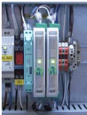
Figura 10: Moduli I/O mod. DAT 3015-I a 4 ingressi analogici.
